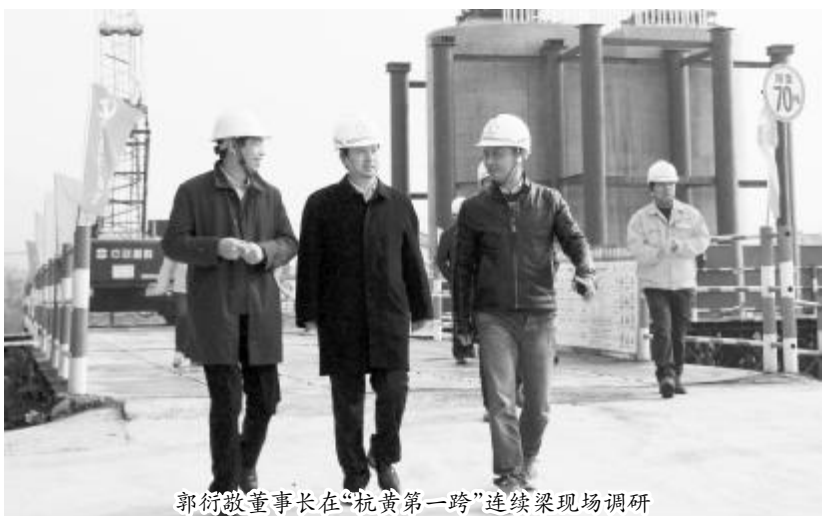
郭衍敬董事长在“杭黄第一跨”连续梁现场调研
