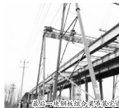
最后一块钢板组合梁吊装完成
