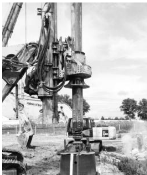
通辽至新民北客专跨甘库铁路特大桥首桩开钻
