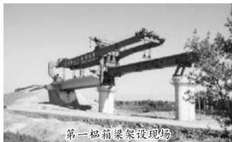
第一根箱梁架设现场
