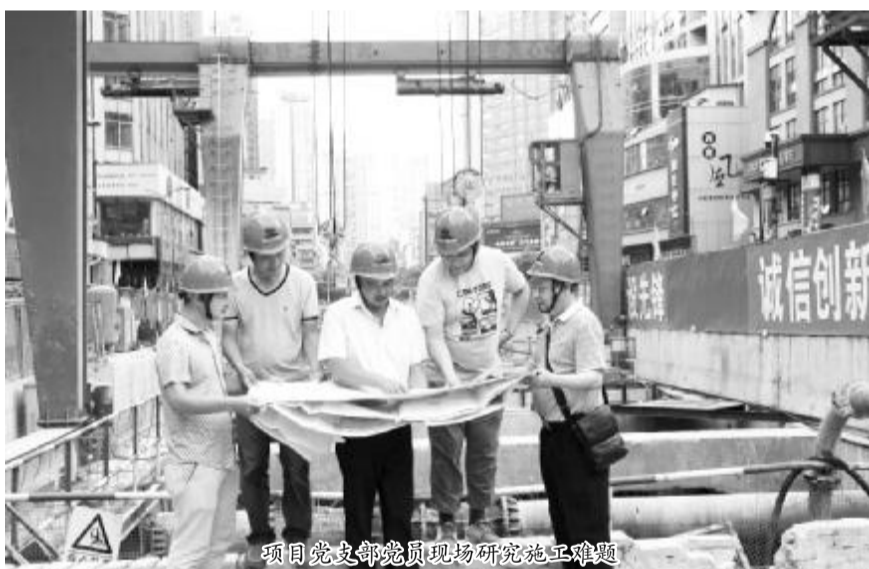
项目党支部党员现场研究施工难题
