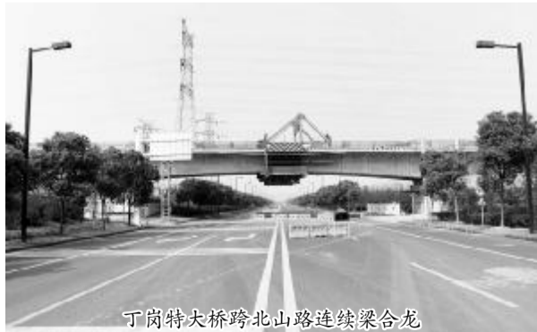
丁岗特大桥跨北山路连续梁合龙
